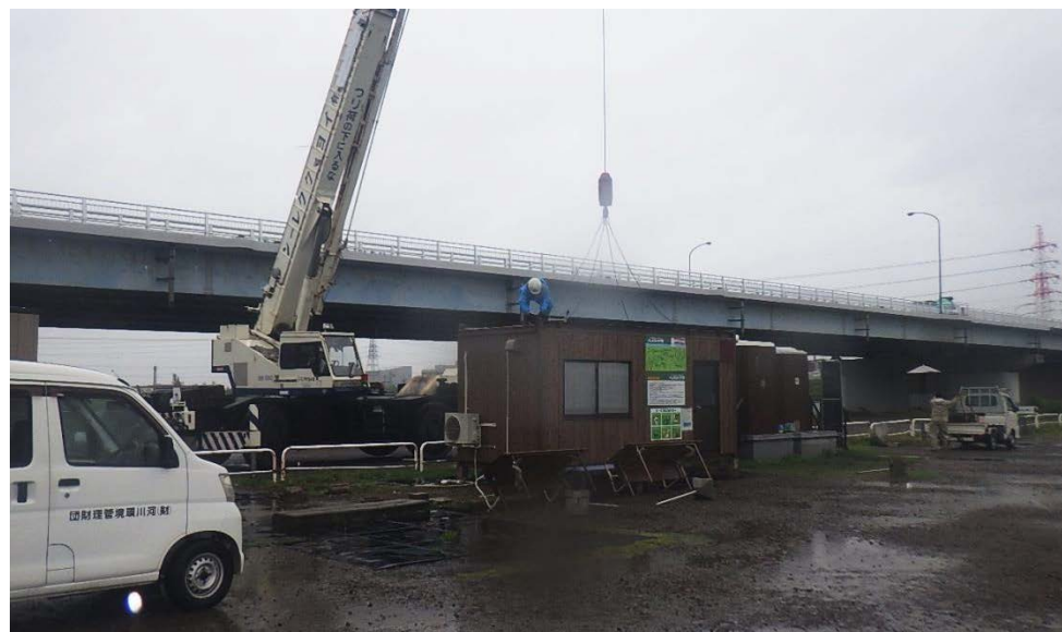
ユニットハウス(受付事務所)をクレーン等により河川区域外へ搬出
